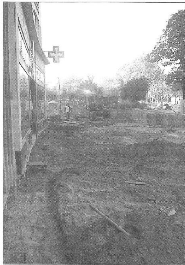
Fin juillet 2005, les travaux du tramway ont rendu acrobatique l'accès à la pharmacie.
