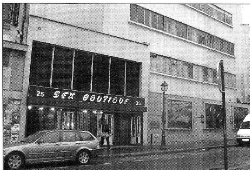
Au 25-27, rue de la Gaîté, une nouvelle construction de logements sociaux va remplacer l'ancien entrepôt et le sex-shop. (PHOTO JACQUES BULLOT)
