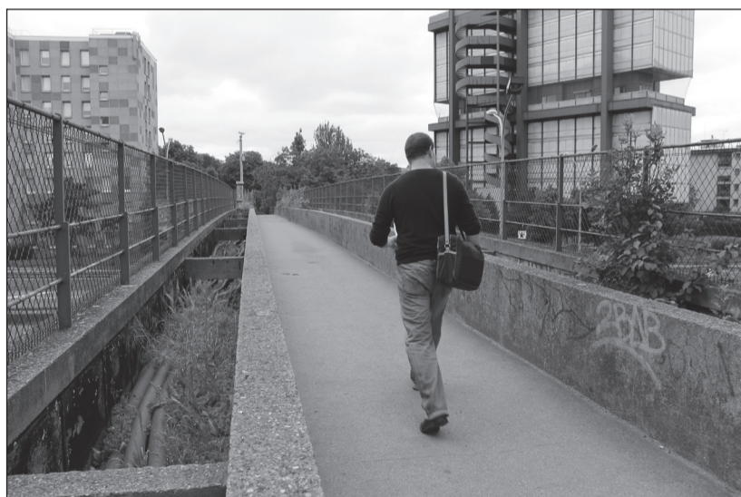
Cela peut aller de la friche industrielle aux abords désertés d'un grand ensemble des années soixante en passant par la parcelle herbacée longeant une autoroute urbaine. (PHOTO : ALAIN GORIC'H)
