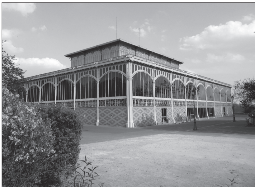
Un pavillon Baltard a été sauvé et remonté à Nogent-sur-Marne. Il est reconverti en espace pluriculturel.
