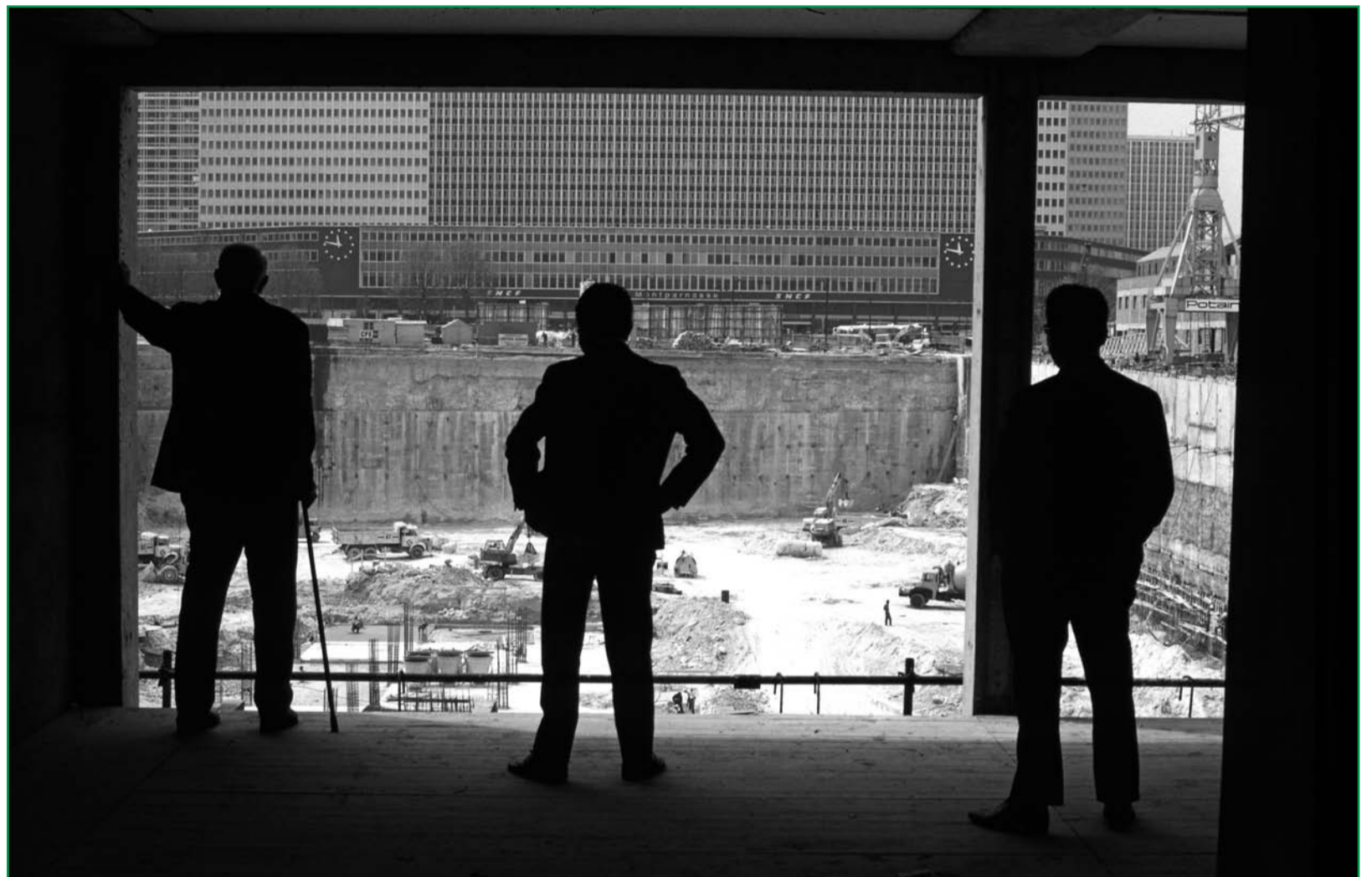
Le chantier de la gare Montparnasse en 1970. (PHOTO : PIERRE JAMET)
