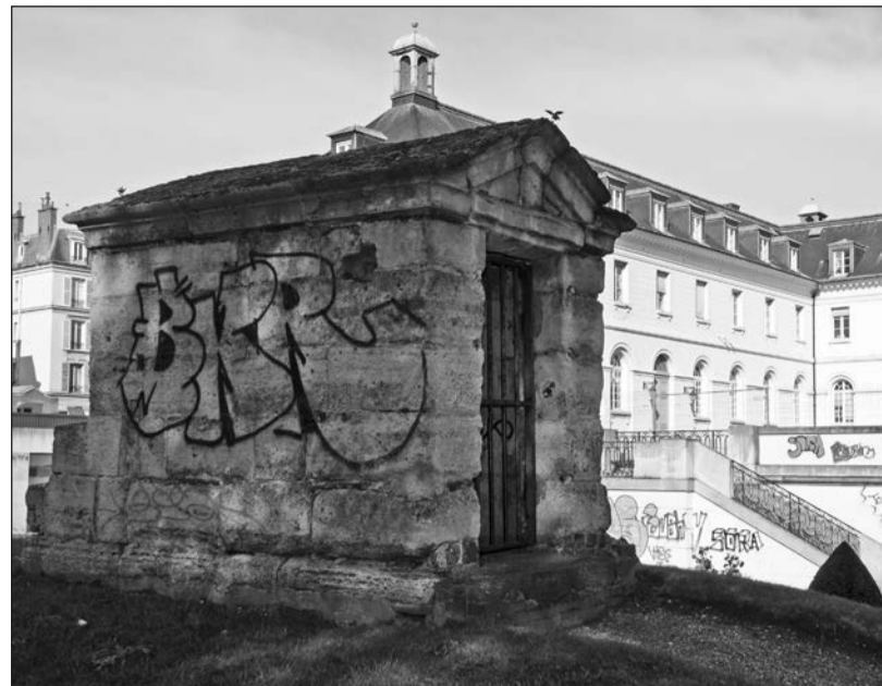
Regard XXV de l'aqueduc Médicis XVII e siècle, à proximité de l'hôpital La Rochefoucauld. (PHOTO : JEAN-MARC JOUANNEAUX)
