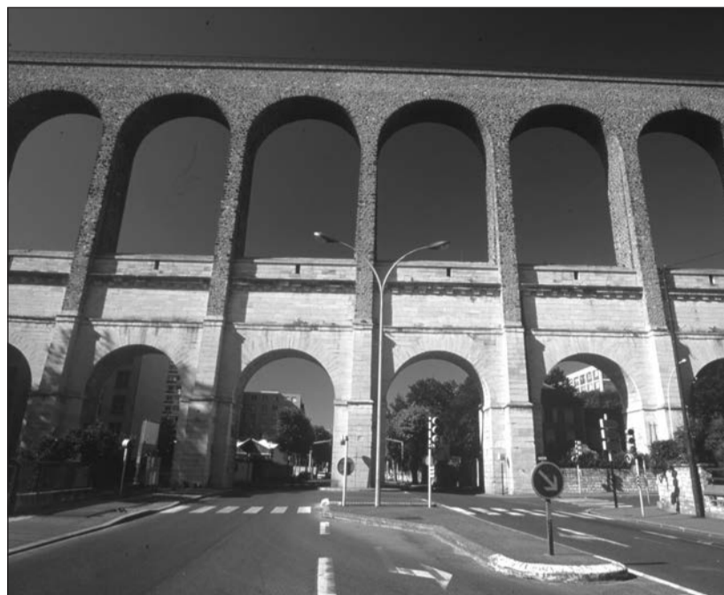
Les deux aqueducs superposés à Arcueil, de Médicis (XVII e s.) et de la Vanne (XIX e s.). (PHOTO : EAU DE PARIS)
