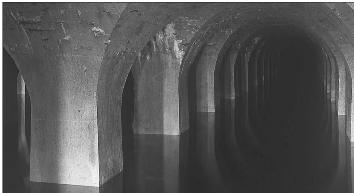
Une étrange forêt de voûtes et de piliers dans les entrailles du réservoir Montsouris. (PHOTO : EAU DE PARIS)
