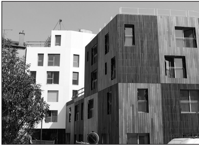
Au premier plan, la façade recouverte de bois de la Pension de famille, côté rue des Thermopyles. (PHOTO : ALAIN GORIC'H)
